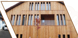
Façade lames en mélèze
