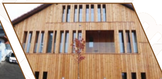
Façade lames en mélèze
