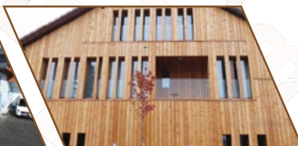
Façade lames en mélèze
