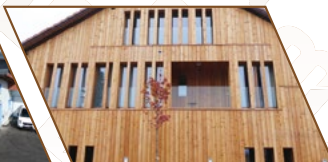
Façade lames en mélèze
