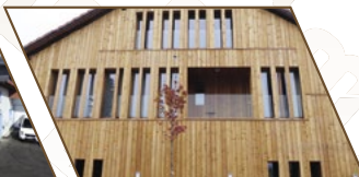
Façade lames en mélèze
