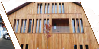
Façade lames en mélèze
